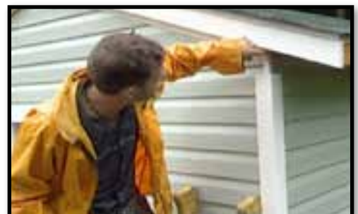
H. Installing fascia.
